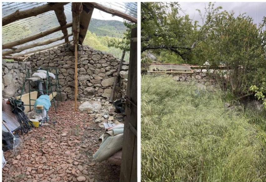
Figura 6. Apuntes y Fotografías Levantamiento Construcción Existente 1. Elaboración propia
